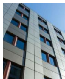
A-23 イトーピア岩本町ANNEXビル
