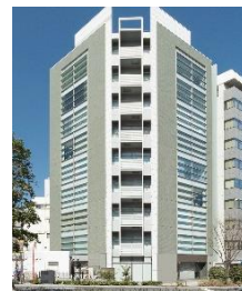
A-59 友泉東日本橋駅前ビル
