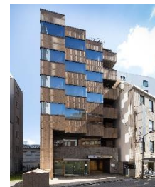
A-68 NRT神田須田町ビル
