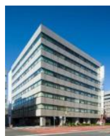
A-39 イトーピア清洲橋通ビル
