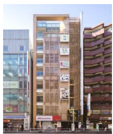
C-1 小滝橋パシフィカビル
