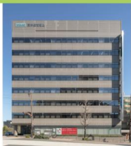
熊本イーストフロントビル
