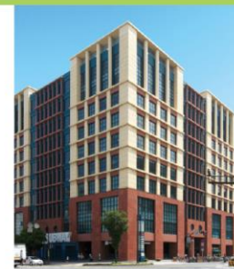
呉服町ビジネスセンター
