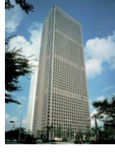
事A-14 新宿センタービル
