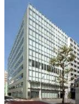
事A-20 JPR日本橋堀留ビル
